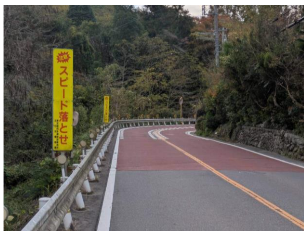
交通量が多く大型トラックも利用する道路で、歩道も狭い場所での点検。
